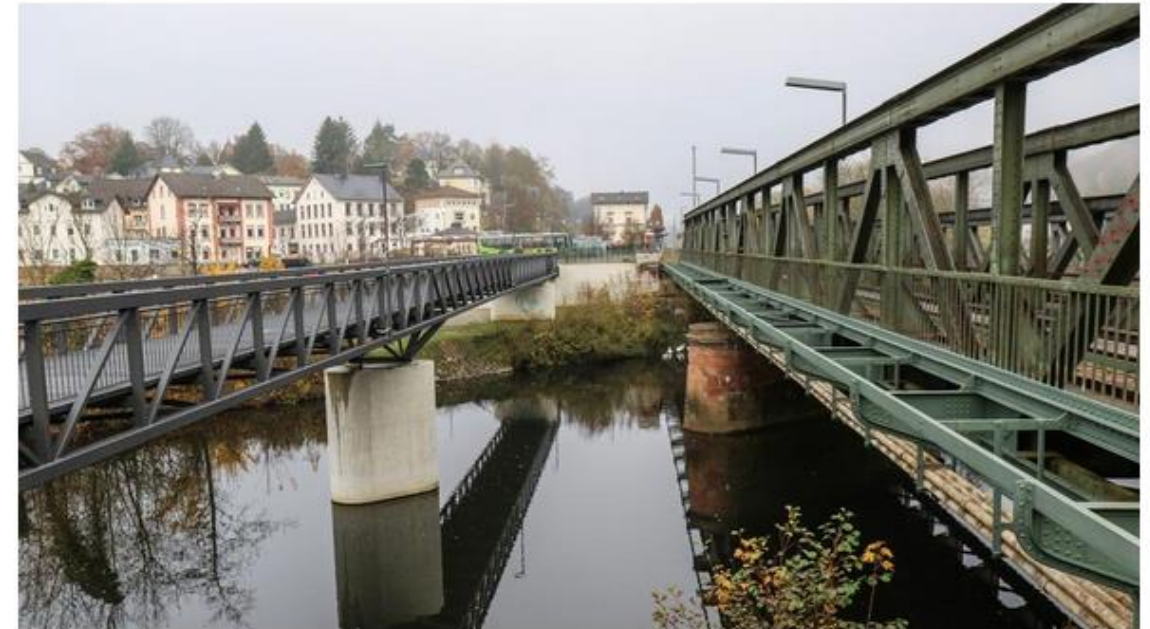
Der "Eiserne Steg" (links), die neu errichtete Rad- und Gehwegbrücke über die Lahn, liegt dir...
