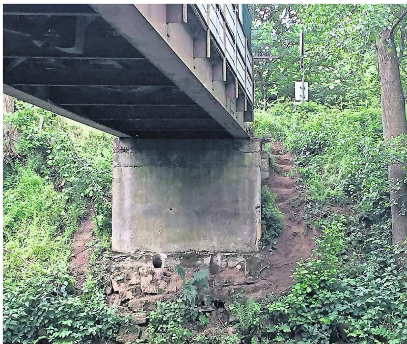
Vor zwei Wochen fanden an den Pfeilern von Isenbergs Brücke bei Goßfelden Kernbohrungen statt.
