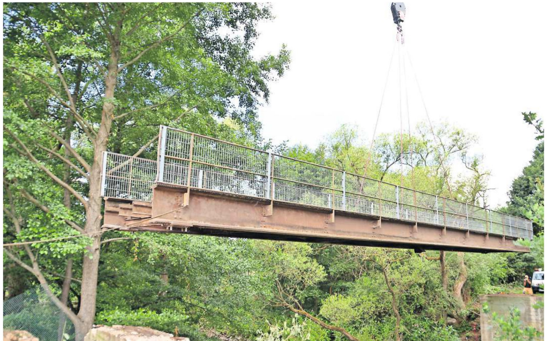
Seit den 1960er-Jahren führte der eiserne Steg am Ortsrand von Goßfelden über die Lahn – nun wurde die Brücke abgerissen. Die Holzbohlen im Stahlgerüst der Brücke waren morsch (kleines Foto rechts).
