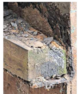
Seit den 1960er-Jahren führte der eiserne Steg am Ortsrand von Goßfelden über die Lahn – nun wurde die Brücke abgerissen. Die Holzbohlen im Stahlgerüst der Brücke waren morsch (kleines Foto rechts).
